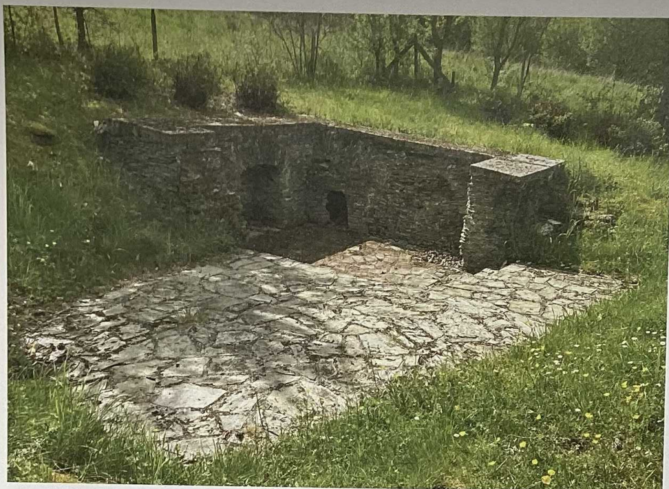
Abb. 7: Teil der Heizanlage des römischen Landguts in Kinheim-Kindel.
